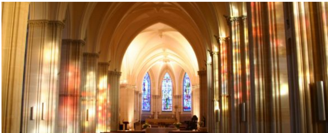
Zoom sur les travaux de la Chapelle de Conflans
